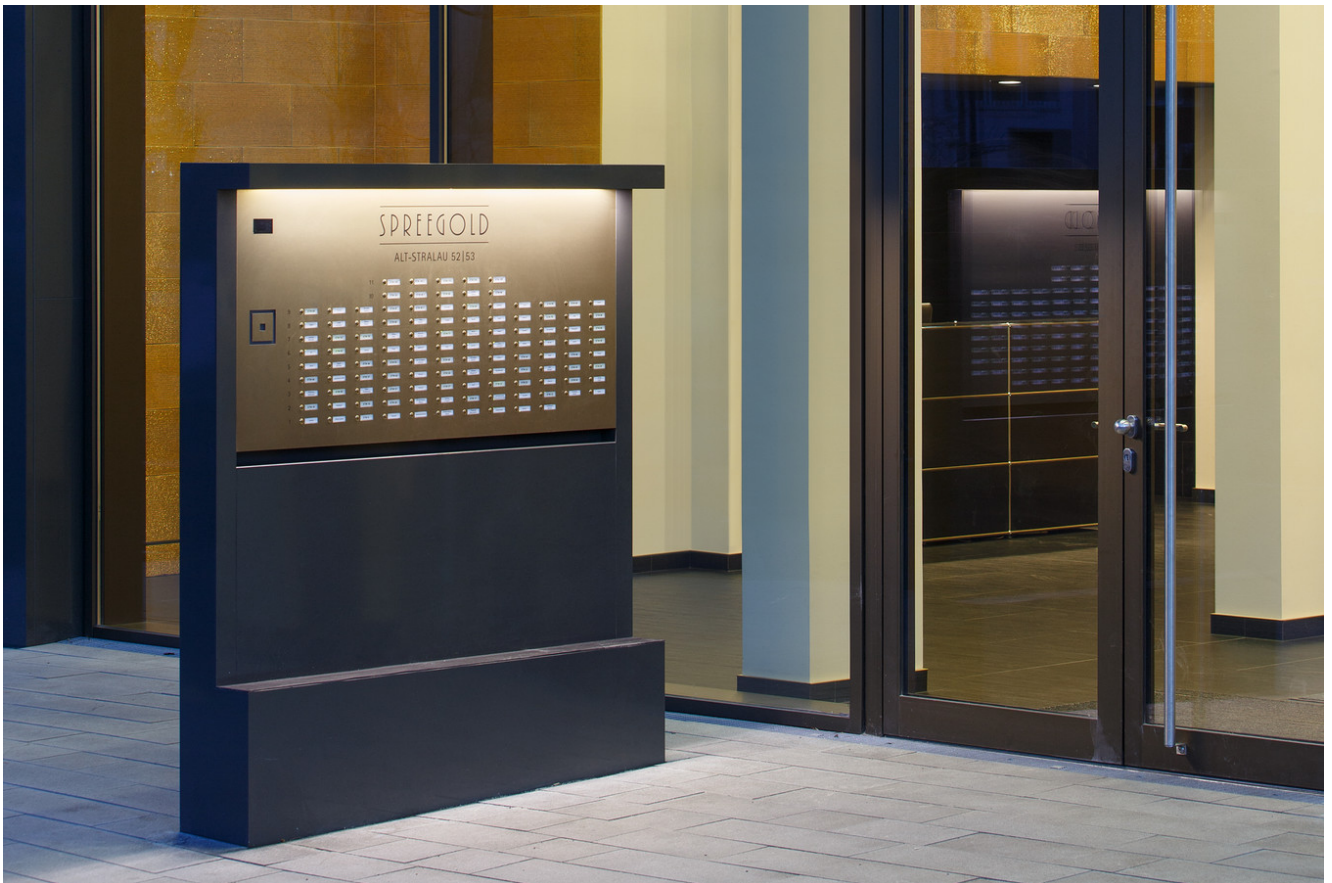
Lippert Berlin: Spreegold, Sanierung von Maske & Suhren Freistehendes Element mit integrierter Videosprechanlage und LED-Beleuchtung. Trittfläche und Griffleiste zur kindergerechten Bedienung. Briefkastenanlage mit integrierter LED-Beleuchtung.
